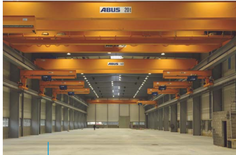
New assembly area / nouveau hall d'assemblage
