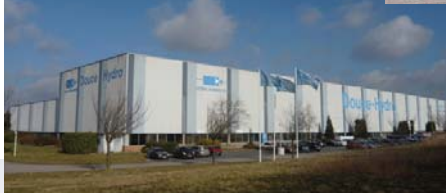
Before construction / Avant travaux
