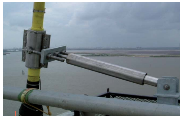
Viscous dampers for cable stays Amortisseurs viscoélastiques pour câbles tensionneurs de pont
